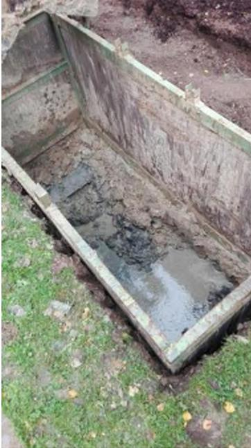
Der Verbaukasten (1,50 m Tiefe) ist noch nicht vollständig in den Boden eingelassen. Es finden sich ab Sarg-Oberkante sowohl schlecht zersetzte Überreste als auch Grundwasser.
