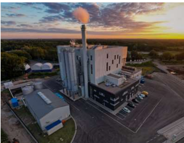
Abbildung 47: Klärschlammverwertungsanlage in Hannover-Lahe
