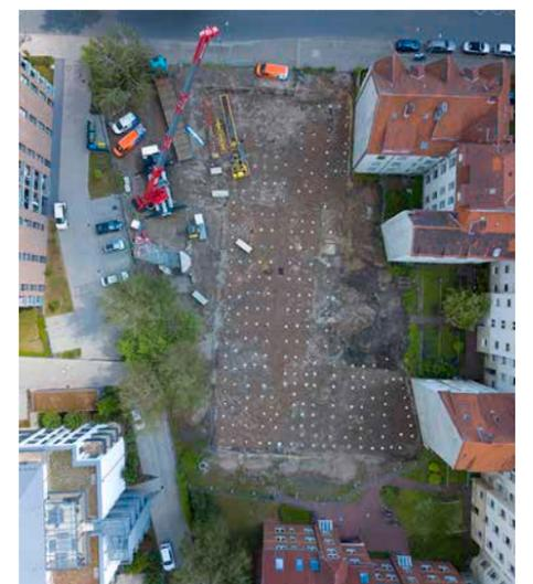
Beeindruckender Blick von ganz oben: 300 Bohrpfähle bieten einen stabilen Grund für die Tiefgarage. Foto: Ralf Mohr
