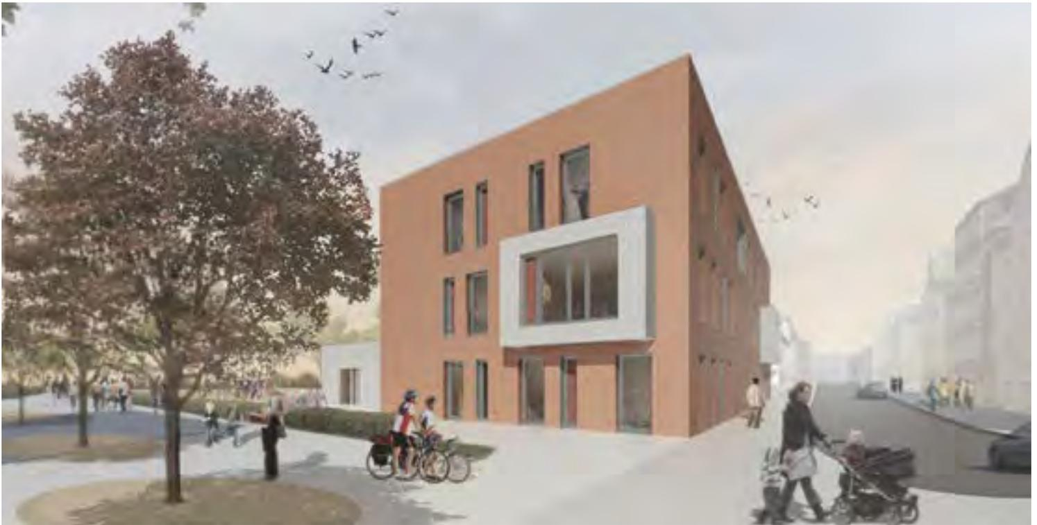
bäudes erhält eine Fassade mit Verblendmauerwerk, der Erweiterungsbau im Erdgeschoss wird mit einer hinterlüfteten Holzfassade bekleidet. Die bodentiefen Holz-Aluminiumfenster in den Obergeschossen erhalten verglaste Geländerbrüstungen. Um im Sommer eine natürliche Nachtauskühlung zu realisieren, werden in den Aufenthaltsräumen Lüftungsfenster eingebaut, die zum Witterungs- und Einbruchschutz mit Wetterschutzlamellen versehen werden. Die gedämmten Flachdächer erhalten eine extensive Begrünung.
