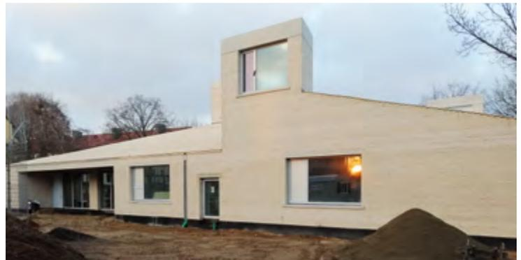
der Südfensteranteil in den Bereichen, die sonst wenig Licht erhalten und fördern darüber hinaus aufgrund ihrer Geometrie und Höhe eine positive Raumluftzirkulation. Die Dachfläche ist für die Installation einer Photovoltaikanlage statisch vorbereitet.
