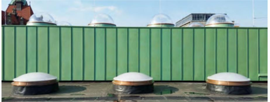
Die einschaligen Oberlichter aus Acrylglas wurden ersetzt durch neue transparente zweischalige Oberlichter unter Verbesserung der massiven Beton-Aufsetzkränze.
