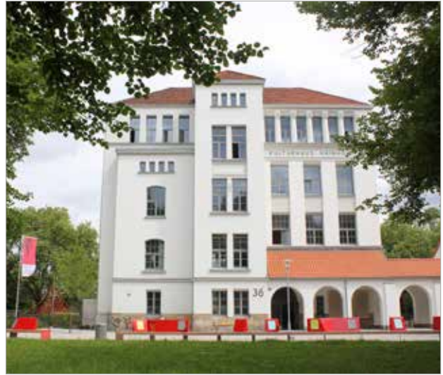
Modernisierung der ehemaligen Alice-Salomon-Schule - heute Kulturhaus Hainholz, Thomas Langreder
