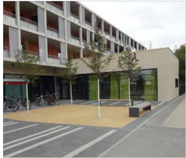
GBH-Neubau am Hainhölzer Markt
