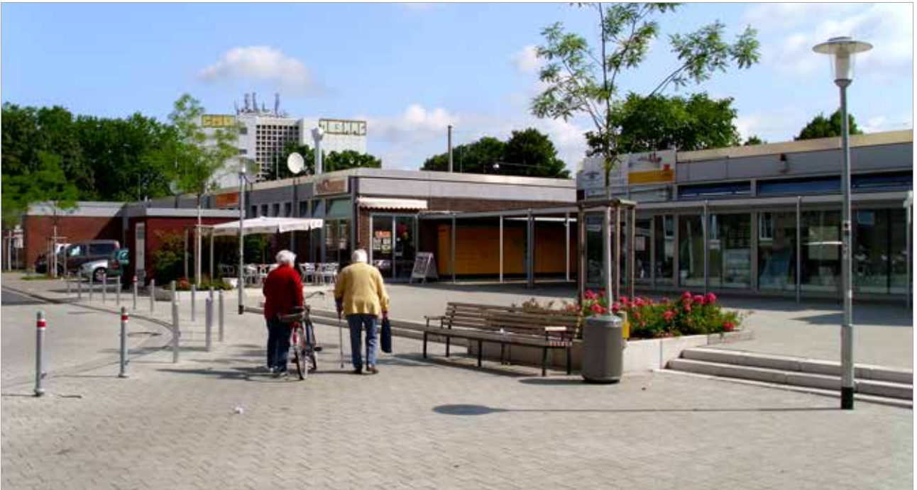
Sanierung der Platzanlage um die Ladenzeile Franz-Nause-Straße
