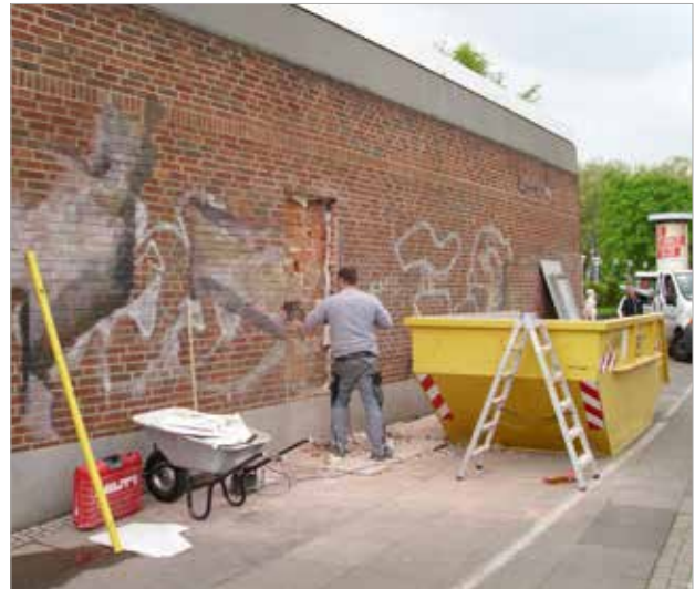
Fassadenmodernisierung Ladenzeile Union Boden
