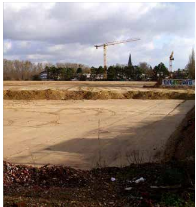
Künftiges Baugebiet Wasserstadt
