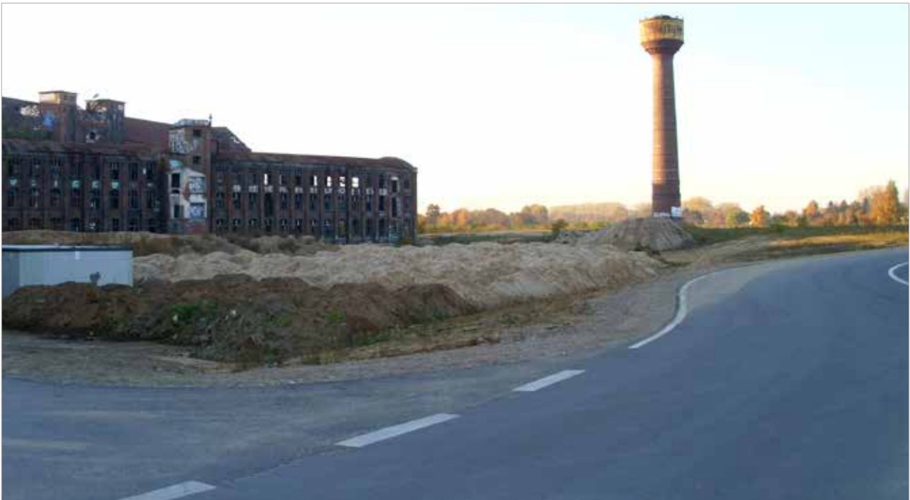
Gebäude und alter Wasserturm des ehemaligen Conti-Geländes
