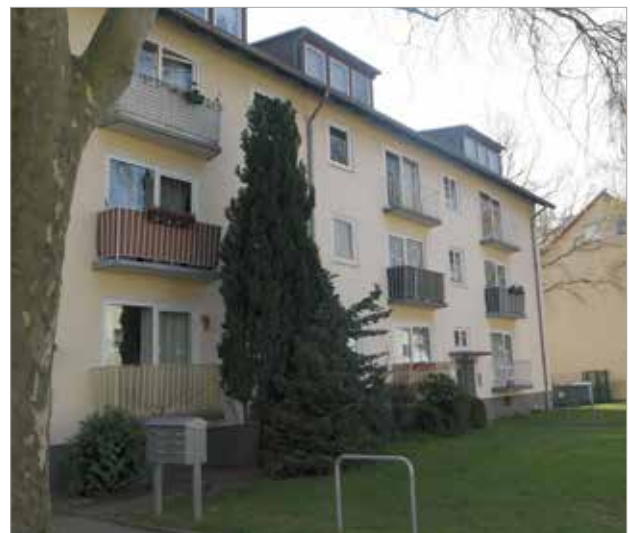
Balkone an der Rintelner Straße
