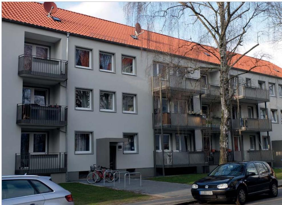
Neben einer energetischen Modernisierung der Wohnungen und einer Anpassung der Bäder und Küchen an heutige Ansprüche werden auch die Treppenhäuser und Hauseingänge erneuert. Die Bömelburgstraße 21, ein Laubenganghaus, wird um eine Etage aufgestockt. Durch den Einbau eines Fahrstuhls wird der barrierefreie Zugang zu allen Wohnungen geschaffen.
