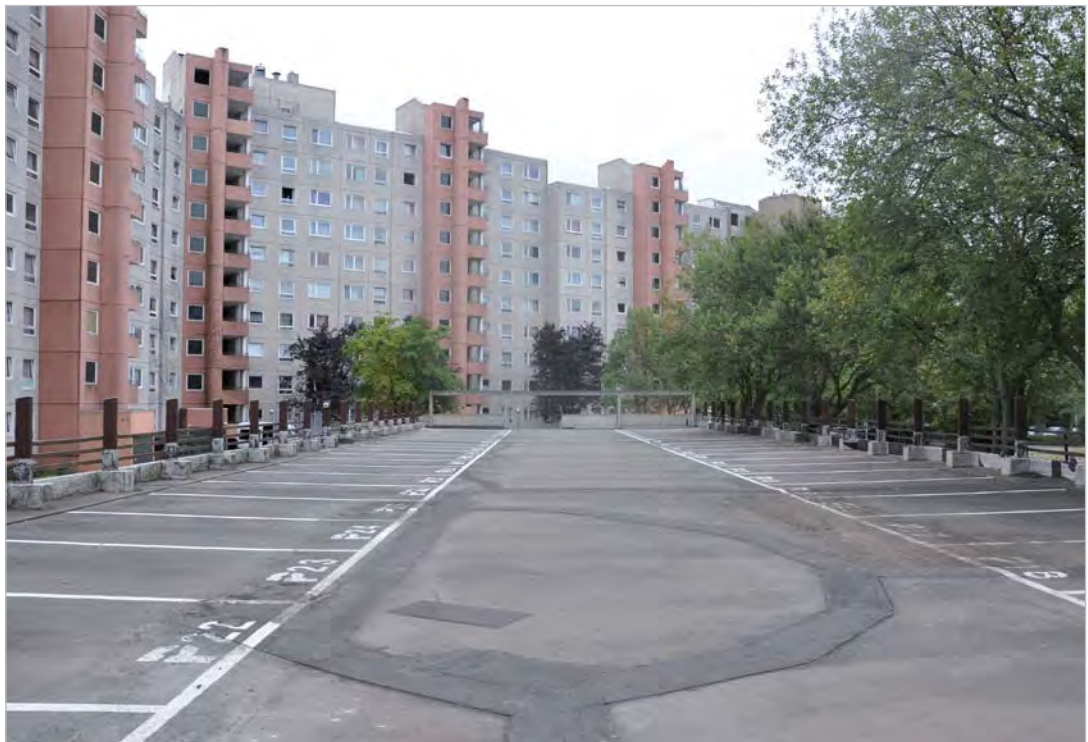
Parkdeck im Innenhof Goerdeler Str./ Ossietzkyring (Büro C. Früh)
