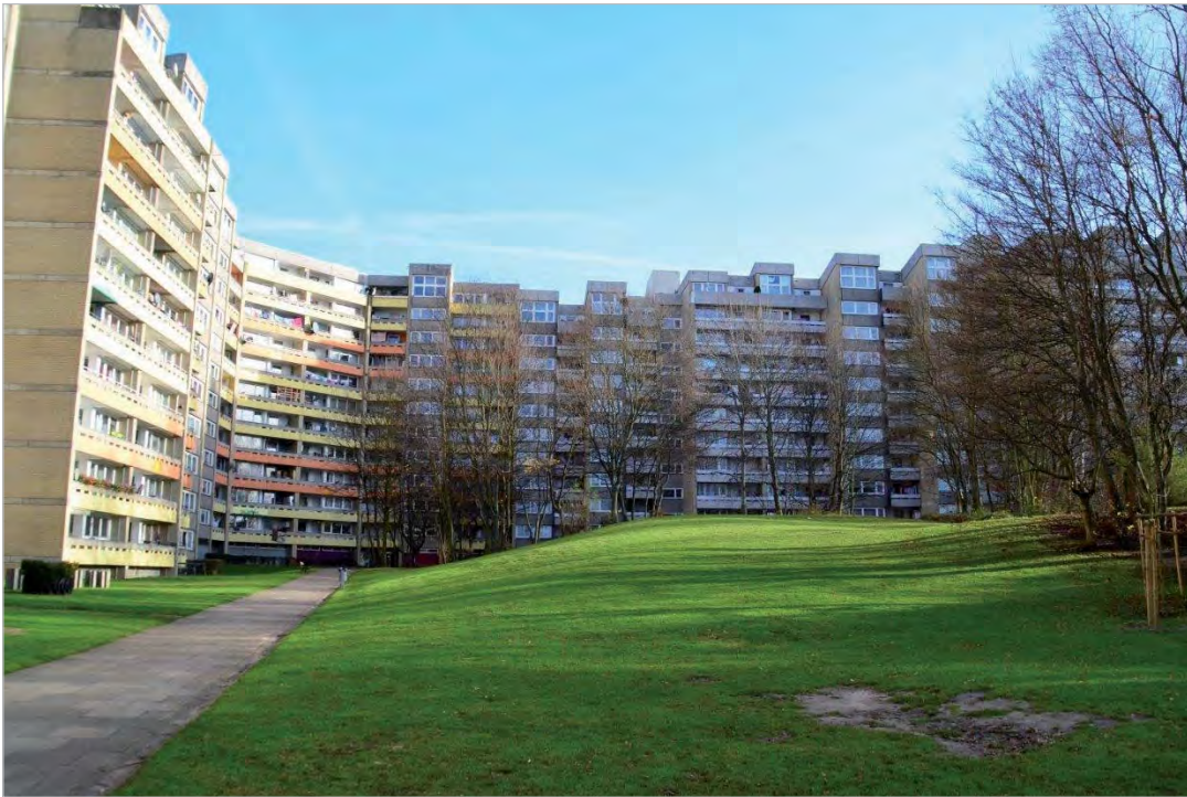
Sanierungsbedarf im Canarisweg (LHH)
