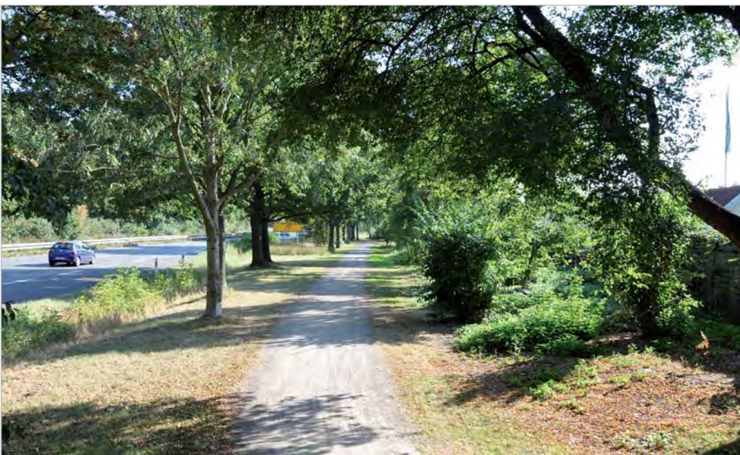
Nebenanlagen Nordseite Beckstraße (Büro C. Früh)
