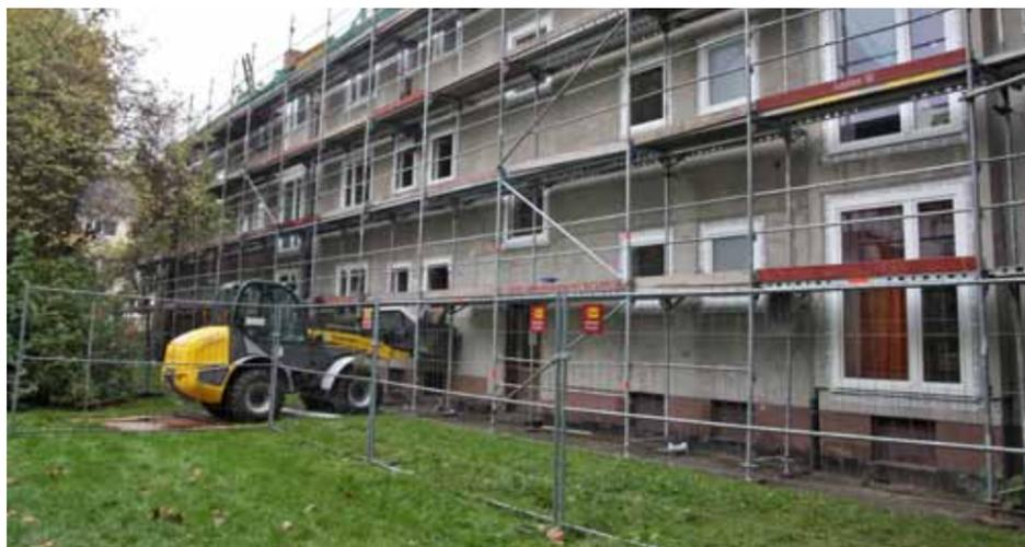
Am Knoevenagelweg werden neue Fenster eingebaut und die Fassade sowie der Dachboden gedämmt.
