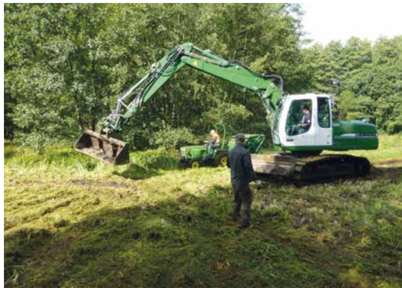
Strukturelle Instandsetzungsmaßnahme einer brachliegenden Feuchtfläche zur Erweiterung einer Orchideenwiese
