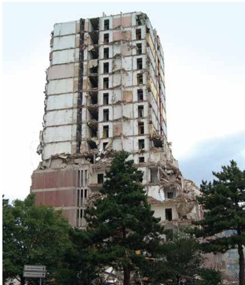
Rückbau eines Schwesternwohnheims
