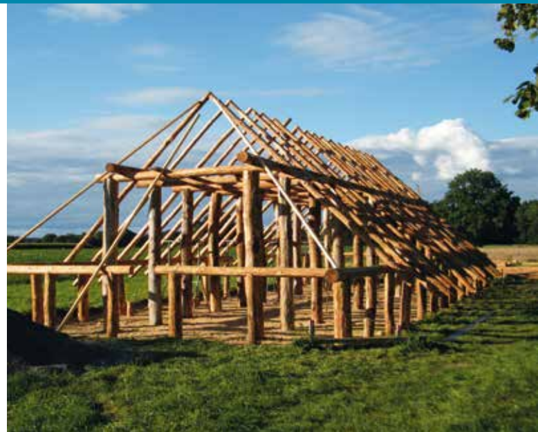
Die Zimmerarbeiten sind abgeschlossen (September 2015)
