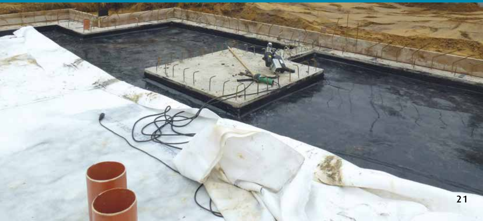
Abdeckung mit Folie und Gleitvlies sowie umlaufendes Verschweißen der Ränder am Ringfundament
