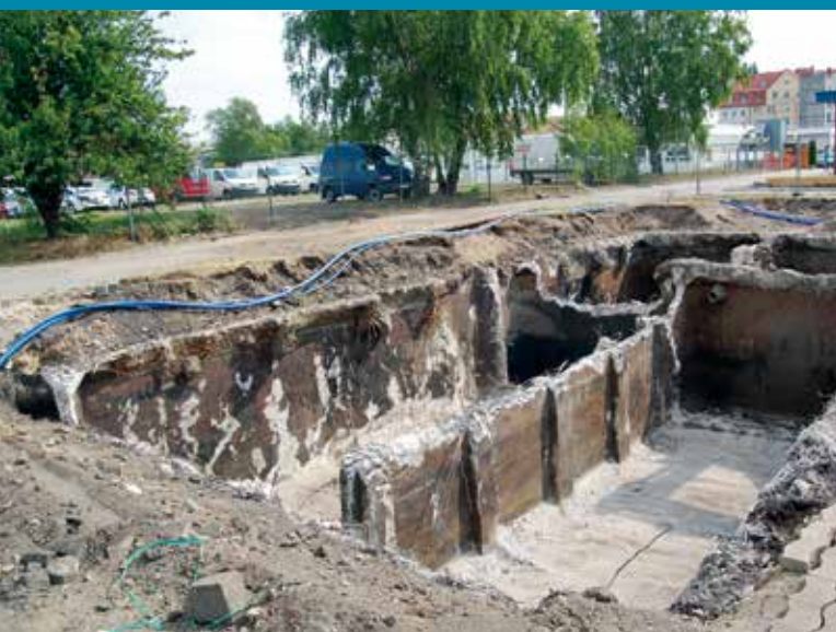
Gebäudefundamente / Absetzbecken eines Gaswerkes
