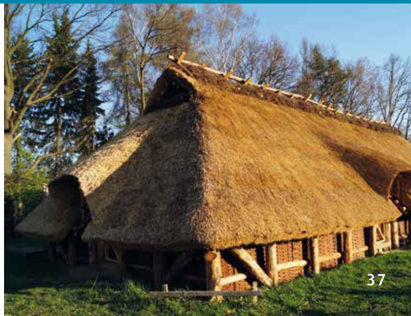
Das Reetdach ist im November 2015 fertig
