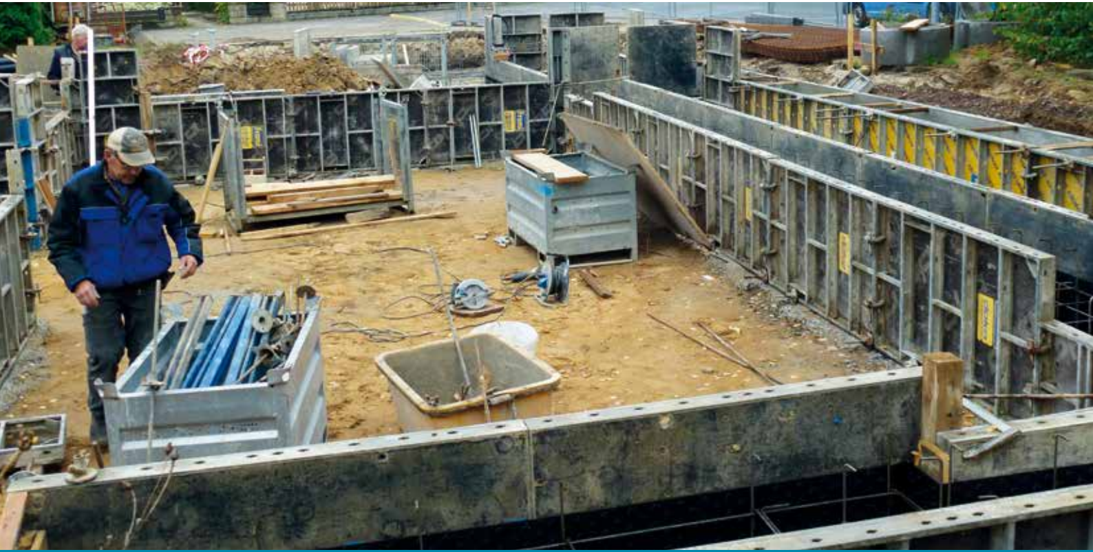
Schalung des Fundamenttringes (EG) mit Schalelementen und Einbau der Noppenfolien oberhalb des Planum
