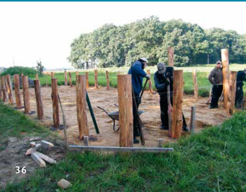
Die von Hand geschälten Eichenpfosten werden einen Meter tief eingegraben (August 2015)
