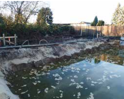
Vollgelaufene Baugrube
