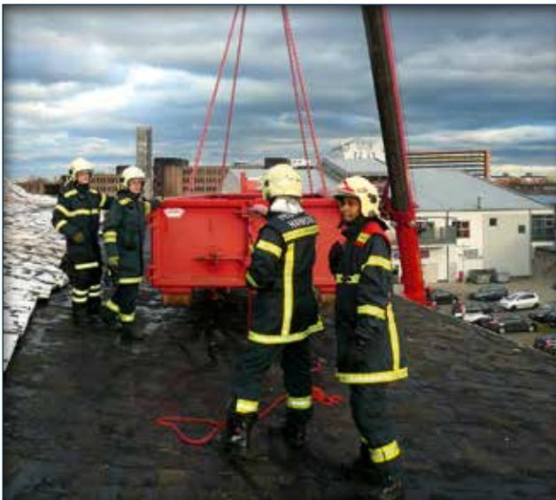
Zum Transport der abgetrennten Dachteile wurde eine Schuttmulde mit einem Feuerwehrkran auf das Dach gehoben (Foto: Feuerwehr Hannover)
