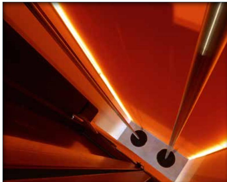
Die Rutschschächte verbinden die oberen Geschosse direkt mit den Fahrzeughallen (Foto: Feuerwehr Hannover)
