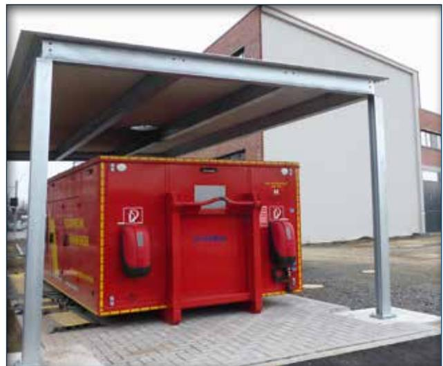
Der AB - Notstrom ist bis auf weiteres fest an der Feuer- und Rettungswache 1 stationiert und dient dort als automatische Netzersatzanlage (Foto: Feuerwehr Hannover)
