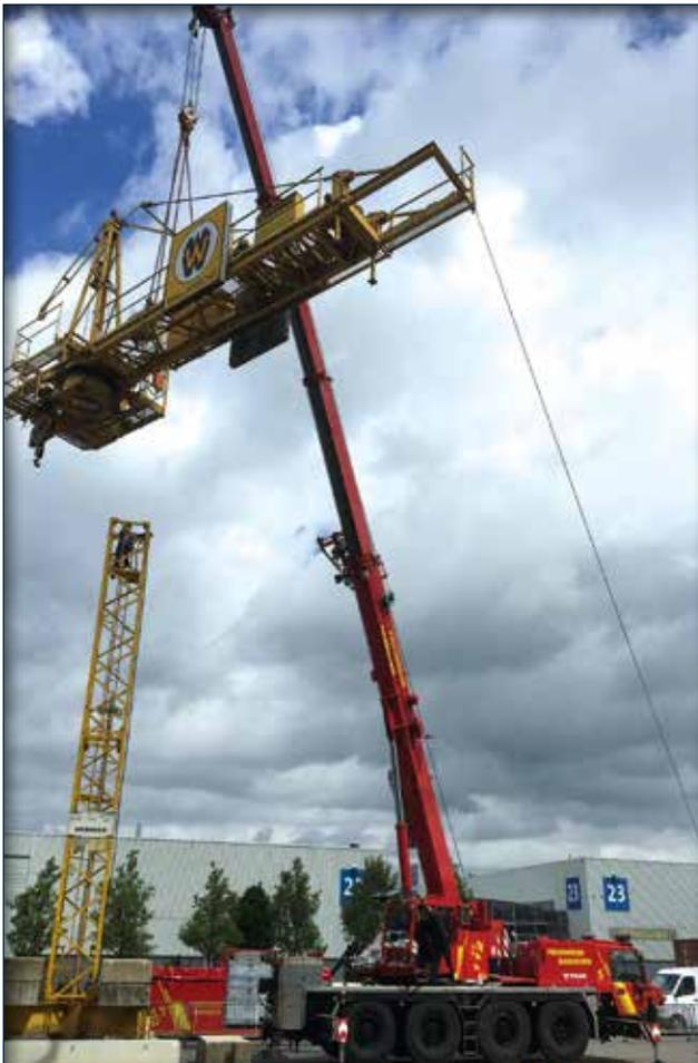
Aufbau des Baukrans für die Rettungsübung mithilfe des Feuerwehrkranes FwK 60 (Foto: Feuerwehr Hannover)
