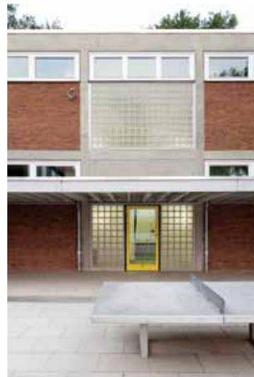
Die denkmalgeschützten **Klassentrakte** und das **Hauptgebäude** mit der Aula wurden sorgsam und denkmalgerecht saniert: Die Betonrahmen der Fassaden wurden saniert, die Mauerwerksausfachungen rostfrei verankert und beschädigte Fugen erneuert. Alle Fenster und Türen, Glasbausteine und Pfosten-Riegel-Konstruktionen wurden energetisch hochwertig und denkmalgerecht ersetzt.
