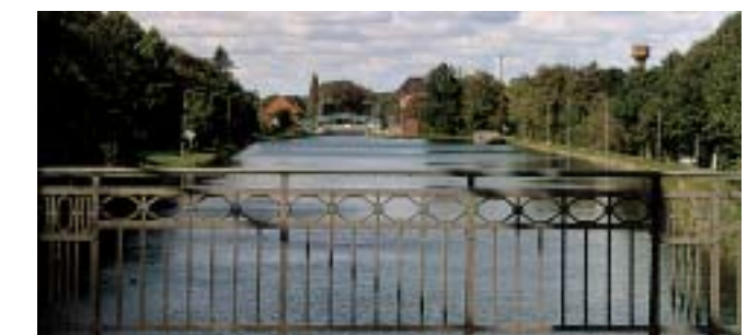
SCHLEUSE AM LINDENER HAFEN
