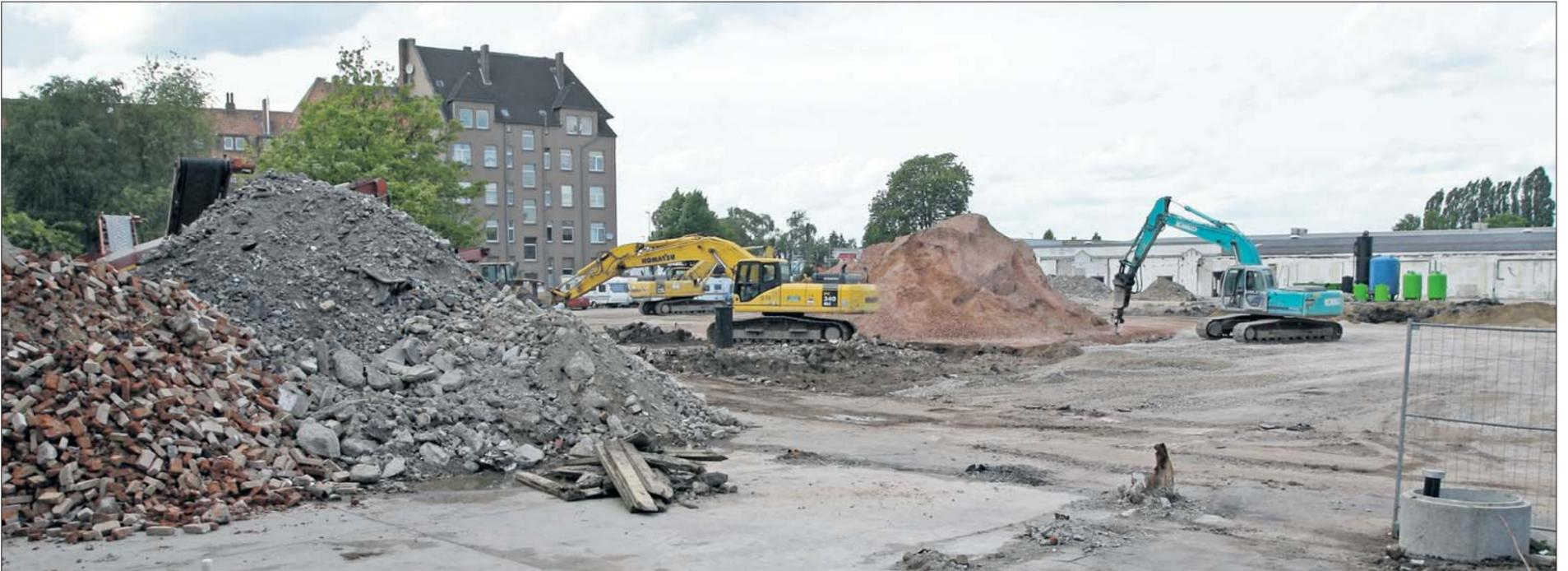
Zum Schutz des Grundwassers: Besonders mit Umweltgiften belastete Teile des Bodens auf dem Sorst-Gelände werden derzeit ausgekoffert und abtransportiert.
