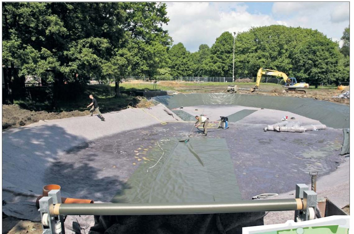
Das große Regenerationsbecken ist fertiggestellt. Hier dichten Arbeiter den Boden ab.
