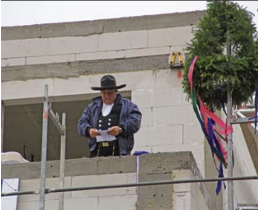
Mit Zimmermannspruch und Richtkranz wurde ein wichtiger Meilenstein beim Bau der Seniorenwohnungen gefeiert. Auch viele der künftigen BewohnerInnen kamen zum Richtfest.
