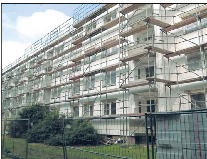
Sahlkamp 87: Die alte Fassade ist hinter dicken weißen Dämmplatten verschwunden. Außerdem wurden bereits neue Fenster eingesetzt.
