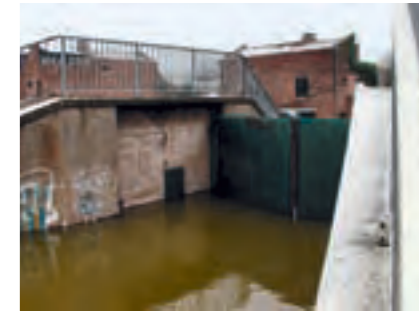
Das Wasser steht 2003 am geschlossenen Deichtor in Ricklingen.
